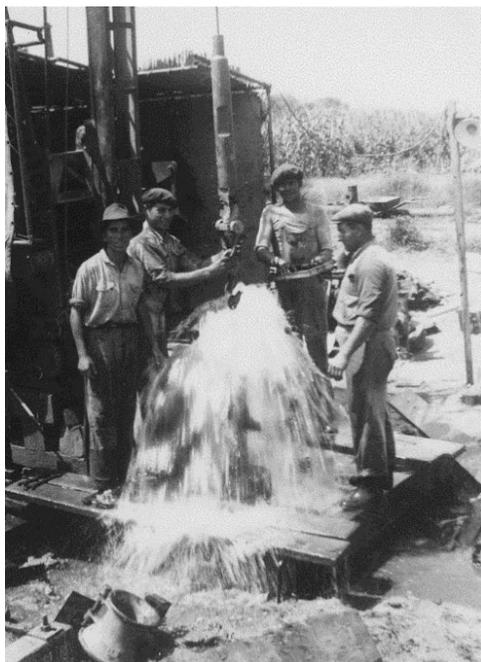
Fig. 2. Construção de Furo de Captação em Almada (1951)
